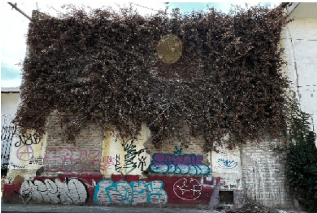
Figura 11: Estado inicial de la fachada a intervenir, “Casa de las Animas”.
